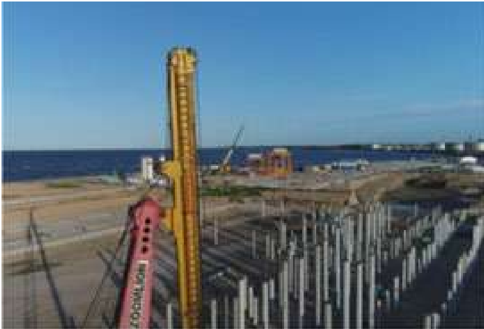
Vista general de pilotes hincados
