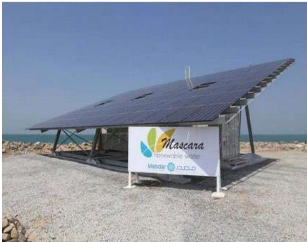
Proyecto piloto de Mascara en Masdar alcanzó el reconocimiento al consumo mínimo de energía específico con 2,5 kWh/m 3 Diseñar listón de premio con: N1 MASDAR PILOT PROJECT
